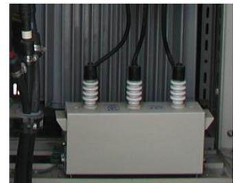
建設時のコンデンサ容量は、動力変圧器容量の1/3を標準として選定されています(最近の設備では小さくなっています)。一般的な、受電設備容量の1/2負荷程度の運用での受電電力では、過剰補償での進相状態となり、無効電力がカウントされることはほとんどありません。進相が大きい場合、電力使用が少ない夜間等に、電気理論で「フェランチ効果」と呼ばれる、受電電圧異常上昇が生じる恐れもあるとされています。
