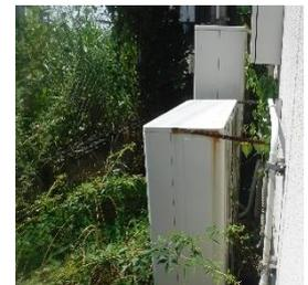
建物等で、デザインなどのために、外壁・廊下などの窪み(アルコープ)内へ設置される場合があります。室外機は屋外の通風が良い所への設置が効率運用のための原則ですが、最低でも壁等とはメーカー推奨の間隔を取ることに注意が必要です。ドレン排水が不良であると、乾燥ができず、室外機が濡れたままとなるため、漏電発生の原因となり、電氣的・機械的な寿命
