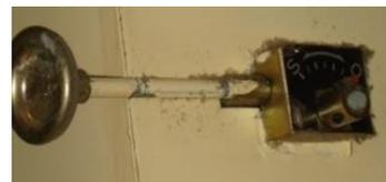
(CO<sub>2</sub>濃度では1000ppm以下、一般に800ppm程度目標)で、閉方向に調整して、外気導入量を削減します。排気で持ち去られる熱量分の空調電力が削減されます。クリーンルームでは、CO<sub>2</sub>濃度の他に、ドア隙間等からの未調質の外気(粉塵などを含む)が流入しないため、最適な正圧(外部に対して10mm H<sub>2</sub>O程度)になるような調整し、ドア隙間などからの常時の排気を生じさせます。周辺部で、クリーンルームの漏れ空気空調が不要として放置されている場合があります。内圧(正圧)を調整し、漏れ空気量を削減します。
