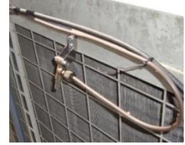
建屋西側の室外機では、日覆いにより日射を遮ると、室外機温度が下がることで、冷房時の効率が上がります。寒冷紗等の柔らかい覆いを使用する場合は、本体ファンに吸い込まれないように注意が必要です。台風等の強風時には取り外しを行うことを考えて設置します。冷蔵冷凍設備の室外機であるコンデンシングユニットも、同様の方法で節電を行うことができます。
