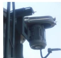
チラー循環の冷却水ポンプもインバータ化できる場合があります。入口(戻り)水温と出口水温の設備点検記録で判断します。
