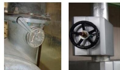
※ コントロールドライブによる、入口ベーンで風量制御されているファン、出口弁での流量制御されているポンプ等には、システム全体としての制御特性(即応性・リニア特性範囲等)の必要性ため、インバータ制御に適さないものがあります。図は電動ドライブのポンプ出口弁です。ポジショナーが付属している空気式等の場合は更に制御特性を考える必要があります。
