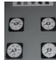
低圧盤上部の変圧器低圧側のメータの例です。変圧器の負荷を算出する(一般的に力率は想定)と、少なくとも、電灯用電力と動力用電力の分担が分かります。指示の精度は高圧用よりも高いようです。電灯又は動力変圧器が複数ある場合、次項の単線結線図と比較すると、部門別等の電力が推測できます。記録表の変圧器容量の変化を見ると、更新時期が分かります
