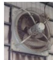
匂い、有害物が発生する等の作業安全上に必要な場合は停止できません。植物栽培用ハウスでの環境維持のための場合も停止できません。ファン定格風量により、換気量が必要量であるかの判断を行い、インバータ追加による可変速運転での風量・電力量削減を考えます。5-4-②節のインバータ化をご参照ください。
