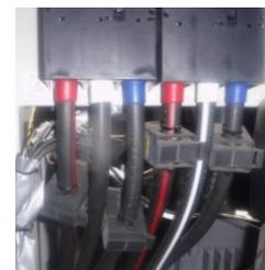
受電設備には、触れると瞬時に感電する高圧部が、低圧部と区画されずに敷設されています。測定時には感電防止に注意が必要です。配電盤での短絡は変圧時二次直下短絡と呼ばれる高圧短絡に類する、噴破を伴う重大事故になります。測定は電気技術員との安全打合せをして実施します。
