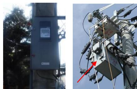
電力量計は計量法に基づく検定品です。封印された計器箱に収納されています。扉を開いての、ユーザーでの内部確認は禁止されています。電力購入先が新電力等であっても、ユーザーへの配電は電力(送配電)会社で行われている(ごく稀に、異なる場合があります)ため、計量方法は同じです。VCT と併せて定期的(法定検定期間満了前)に電力会社により更新されます。
