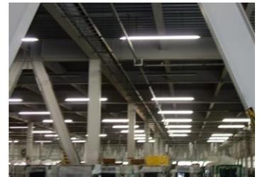
広い工場での、倉庫として使用されている部分など、現状の使用に合わせて考えます。使用頻度の少ない通路部では人感センサにより、通行者を検出しての点灯を行うことができます。
