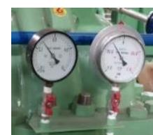
機器異常は設備の運用効率を低下させます。電流の増加、吐出圧力の低下等で判断ができます。記録値と、後述する取扱説明書のポンプ特性図との比較検討で、節電のための運転状態の把握ができます。
