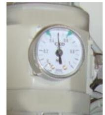
個別機器の動作に必要な圧力を調査し、圧縮空気系統が実際に要求する圧力を検討します。ダンパ等の開閉用シリンダでは、0.2MPa 以上あれば、時間は長くなりますが、動作は可能な場合がほとんどです。清掃用ブローのみで使用の場合は、さらに低い圧力で可能です。供給空気圧の低下に対して、供給量を維持するために、空気配管の径を大きくする方法もあります。
