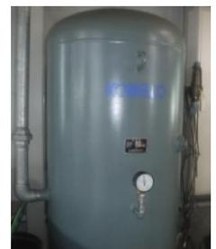
使用機器の入口に、小型のレシーバが設置されている場合は、機器入口での圧力変動は更に少なくなります。空気配管にヘッダ(圧力容器ではない)があっても、同様の効果があります。
