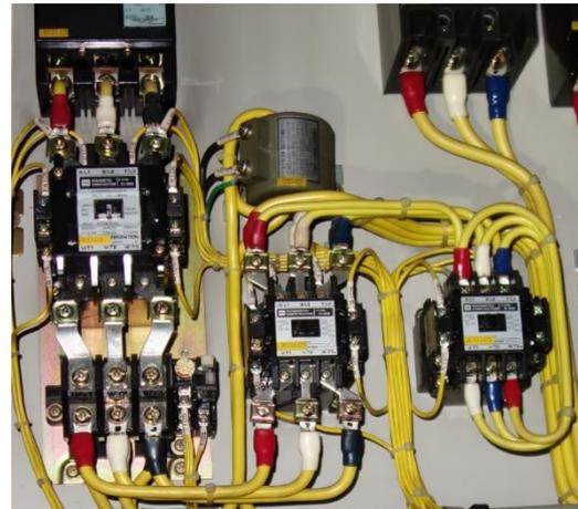
いずれも、上部ラック等に設置された 0.5sec 程度の空転時間を持つ専用タイマーで、MC が切り替えられます。右図は専用タイマーの例で、切替え時間のみの設定（ここでは 10sec）を行っています。
