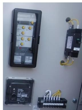
一体型の場合は、DC 電源は共用である。解線したブレーカ二次配線に補助電源を入れる。リレーの RUN の点灯で確認する。
