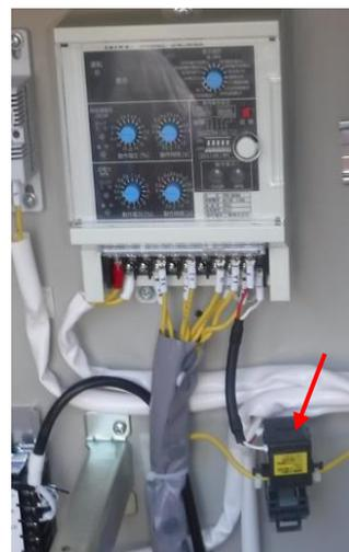
既設の電流線に沿わせて、試験線を貫通させる。この例では、Lt コードを貫通させ、右側で Kt コードとクリップ短絡している。分割 CT には k、l の表示があるので、逆にならないように注意する。細いリード線を準備しておいて通し、両端に Kt、Lt クリップをつけると、分割 CT の開閉が不要で、咬み合わせが甘くならないためにも良いと考えられる。
